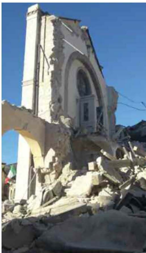
Norcia, la Basilica di San Benedetto dopo il crollo
